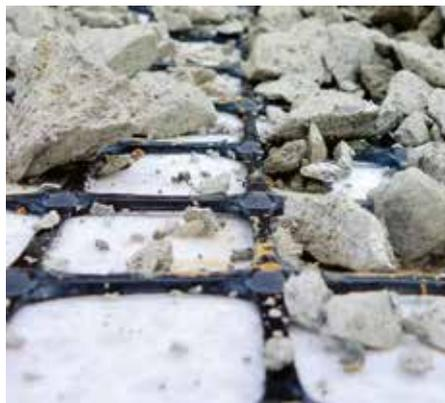
Geogitter haben eine stabilisierende und lastverteilende Wirkung
