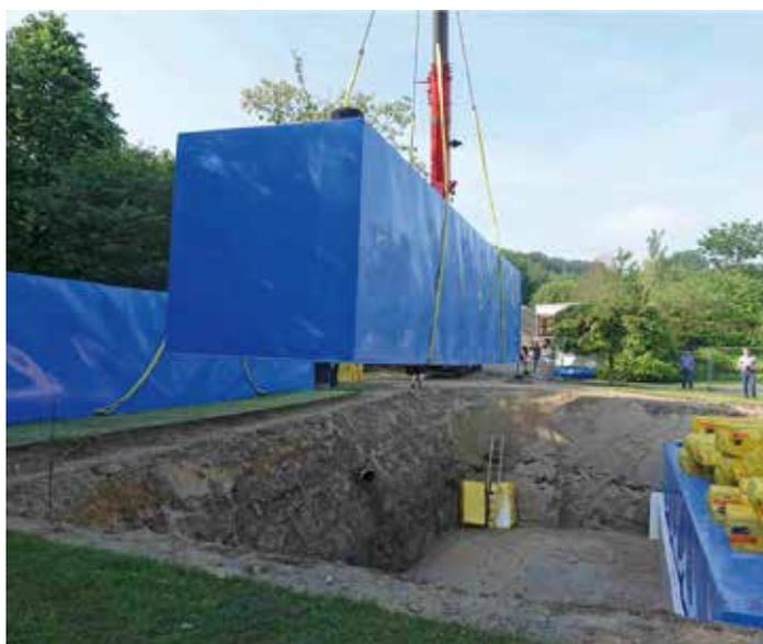
An der Einbaustelle werden die Elemente in die vorbereitete Baugrube gestellt
