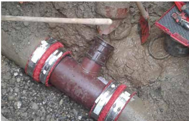
*Sichere und praktische Lösung: Reparaturabzweig nach dem Einbau*
