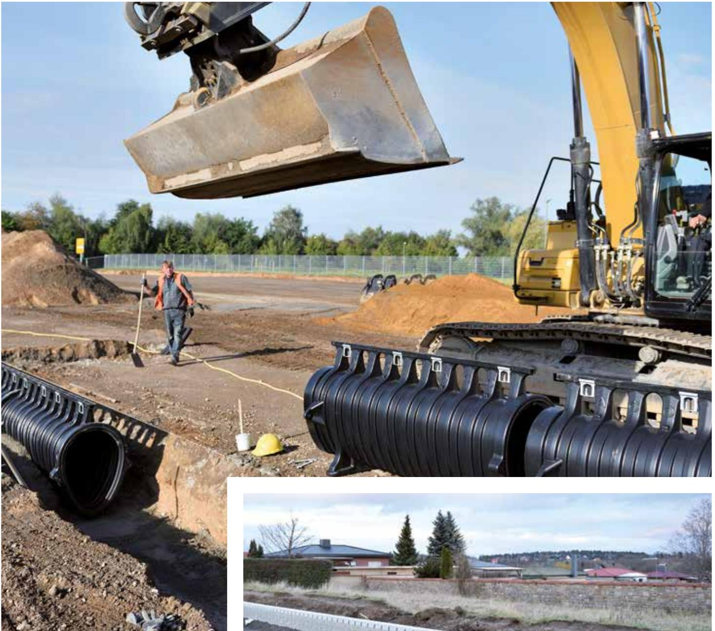
*Die ACO DRAIN® Schwerlast- und Retentionsrinne Qmax ist eine Kombination aus Entwässerung und Retention*
