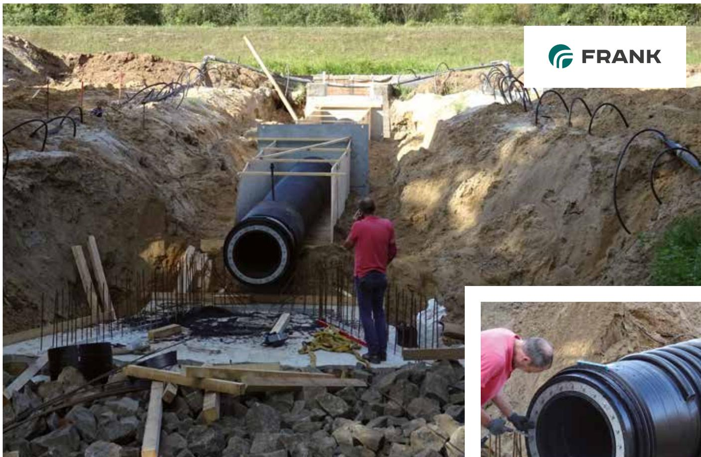
*Sanierung des Ablasswerkes am Ranzaukanal: PKS-Rohre von FRANK ersetzen das korrodierte Stahlrohr*
