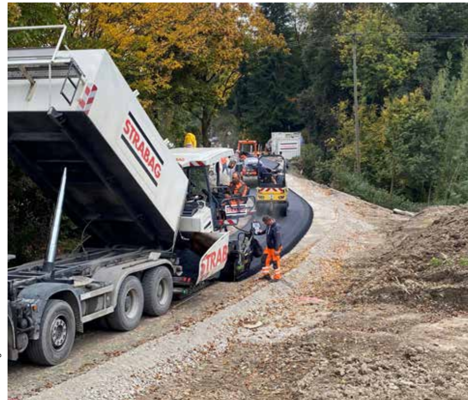
Bild 3: Biobitumen im Einsatz beim Bau eines Radwegs in Wildpoltzweiler mit einer Einbautemperatur von 110°C
