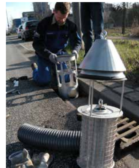
Spezielle Filtersysteme von Funke schützen Kanalisationen vor abgelöstem Mikroplastik
