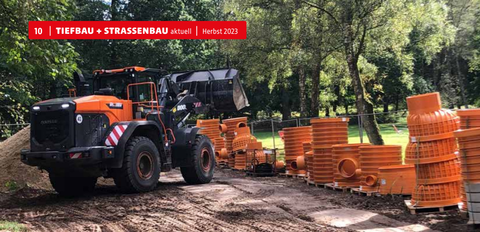
Die Kunststoffschächte und -rohre von REHAU sind extrem lange haltbar, 95 % leichter als Betonschächte und schneller zu verlegen
