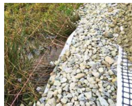
Die Kombination von Geogitter und Vliesstoff gleichen inhomogene Verhältnisse des Erdplenums aus
