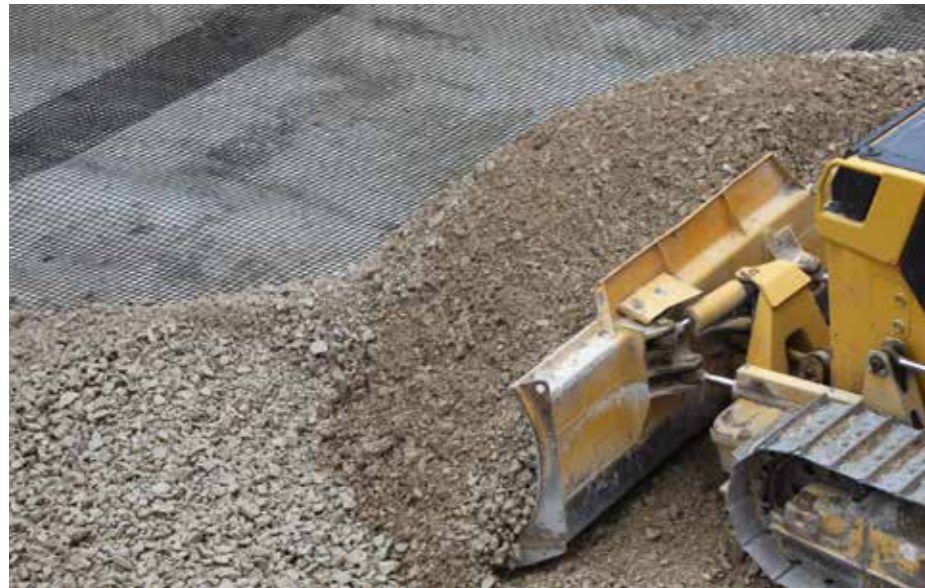
Ein Butler macht's Geogitter spart bis zu 40 cm Aushub und dadurch Kosten für Entsorgung und Ersatzmaterial
