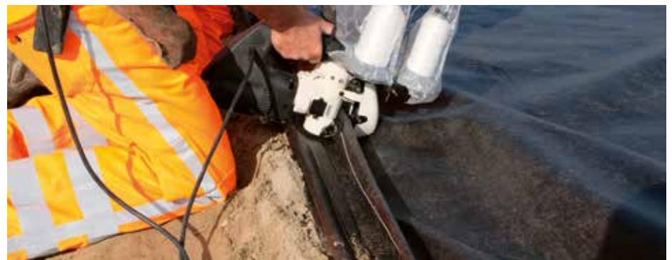
Mit der neu entwickelten Broof-Tech Stitch® Technik werden die überlappenden Streifen des Unkrautvlieses versiegelt
