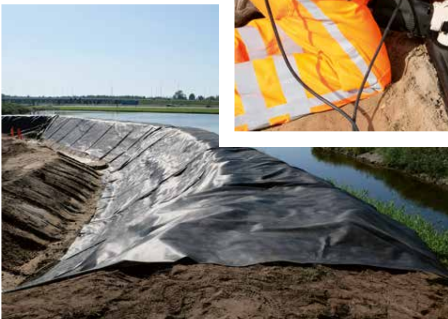
Mit schädlichen Pflanzen kontaminierter Boden kann mit dem wasser- und luftdurchlässigen Spezialvlies abgedeckt oder verpackt werden
