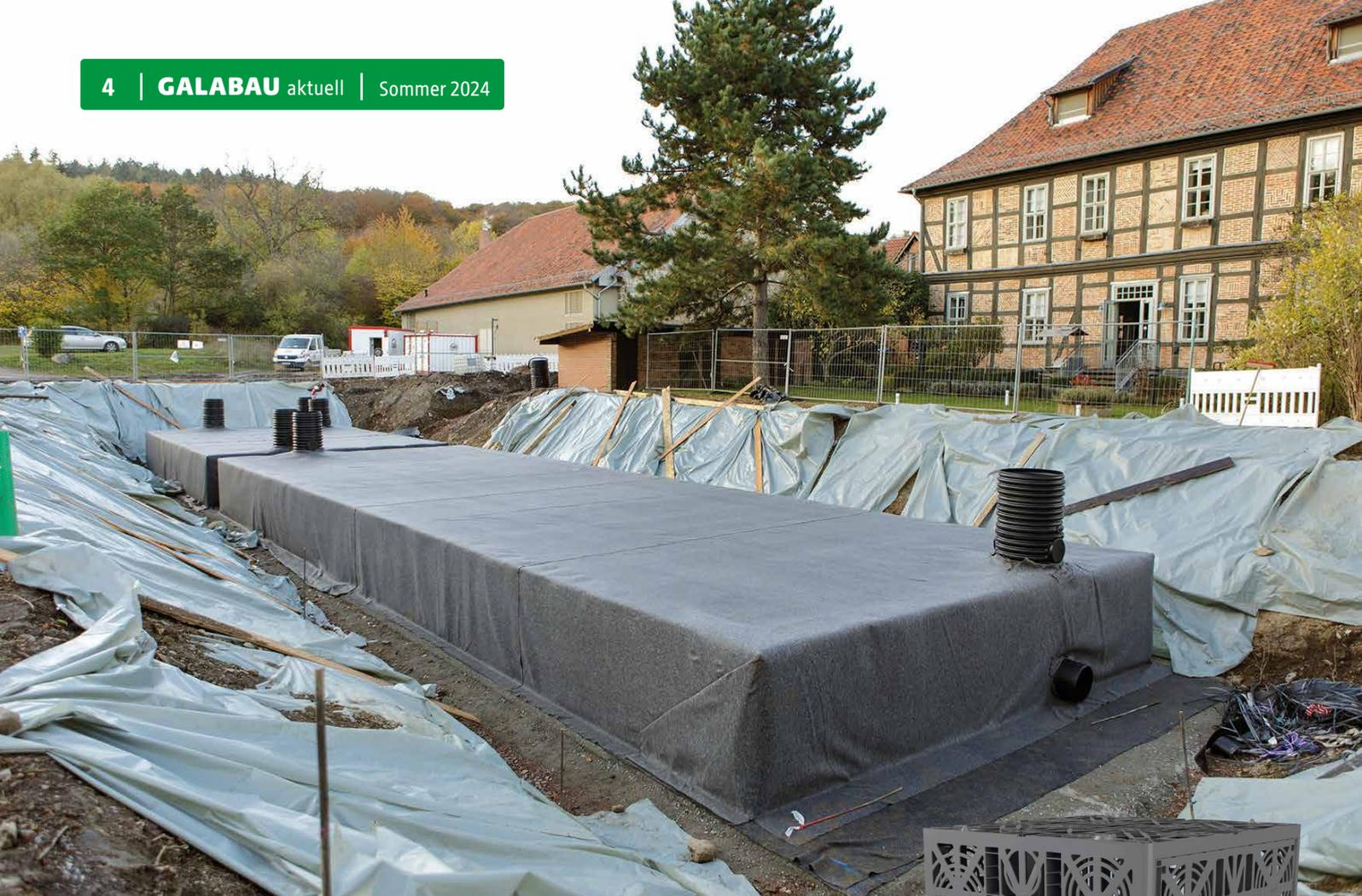
Die unterirdische, kombinierte Regenwassernutzungs- und Regenwasserrückhalteanlage des Klosters Michaelstein wurde mit Rigolenfüllkörpern von GRAF umgesetzt
