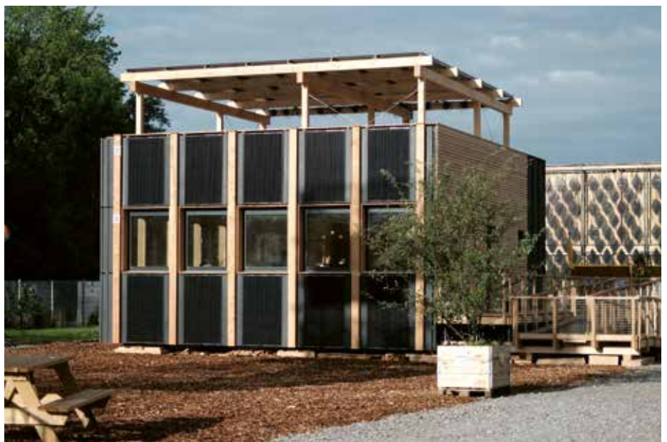
Auf dem Solar-Campus haben 13 Hochschulteams Gebäude-Demonstratoren gebaut
