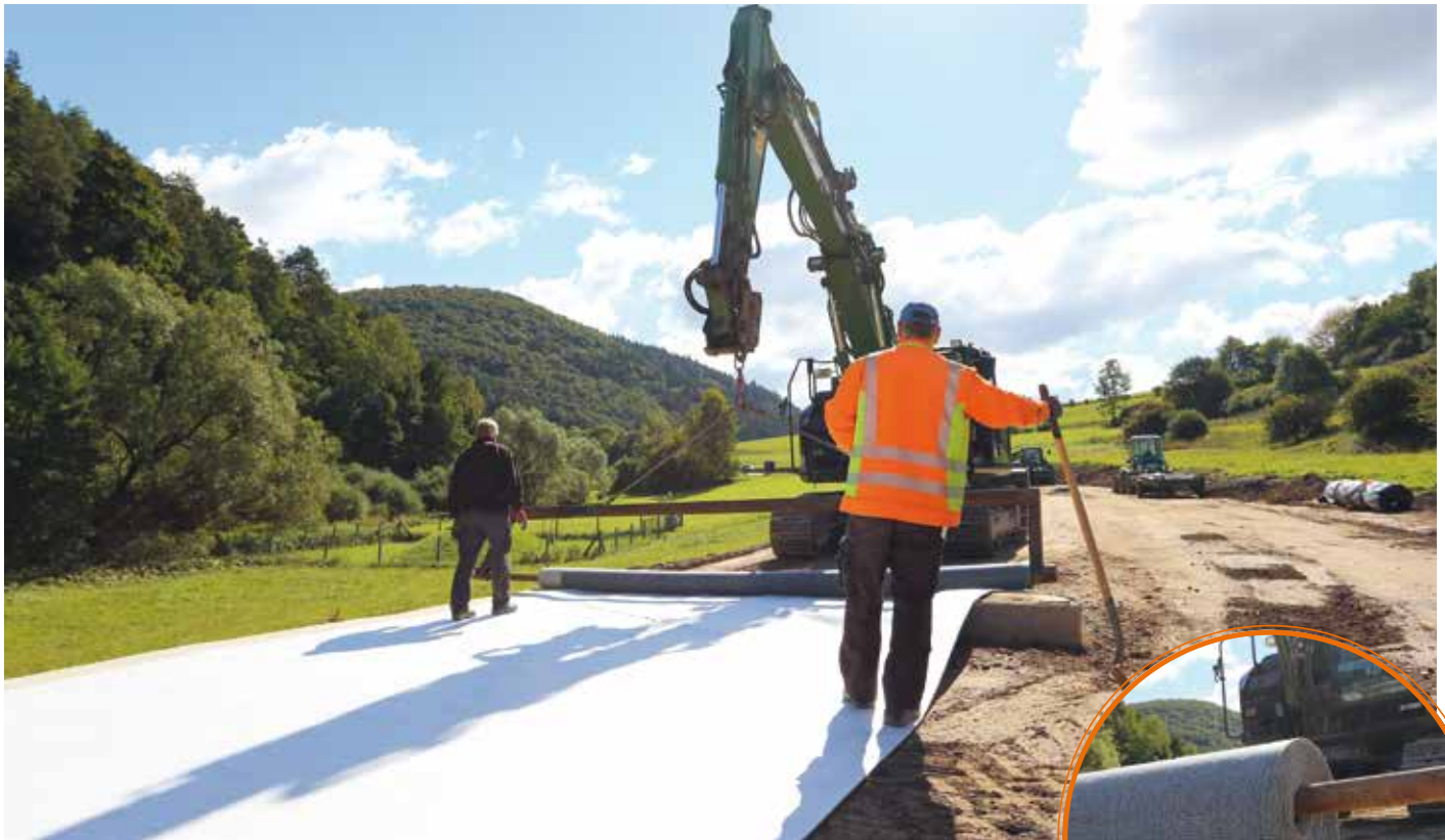
Verlegung einer Bentonitmatte im Straßenbau
