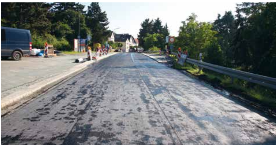
Straße mit Asphaltarmierung – bereit zum Auftragen des Straßenbelags
