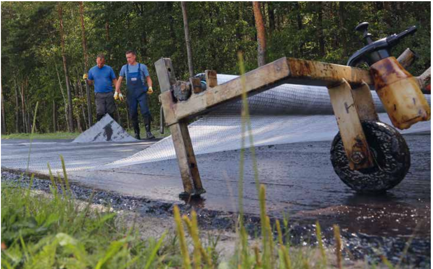
Straßensanierung mit Geotextilien: Verlegung eines Armierungsgitter auf gefräster Asphaltfahrbahn
