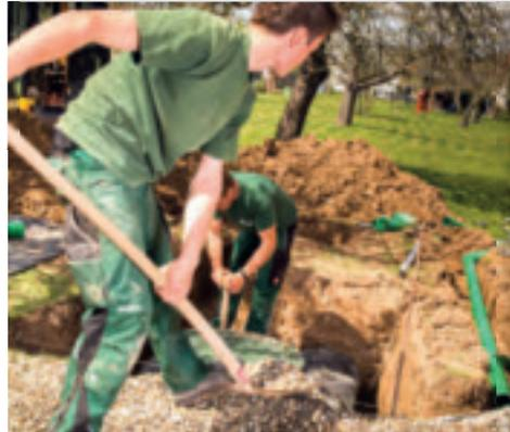
Mit Rundkornkies wird aufgefüllt und verdichtet. 93-04
