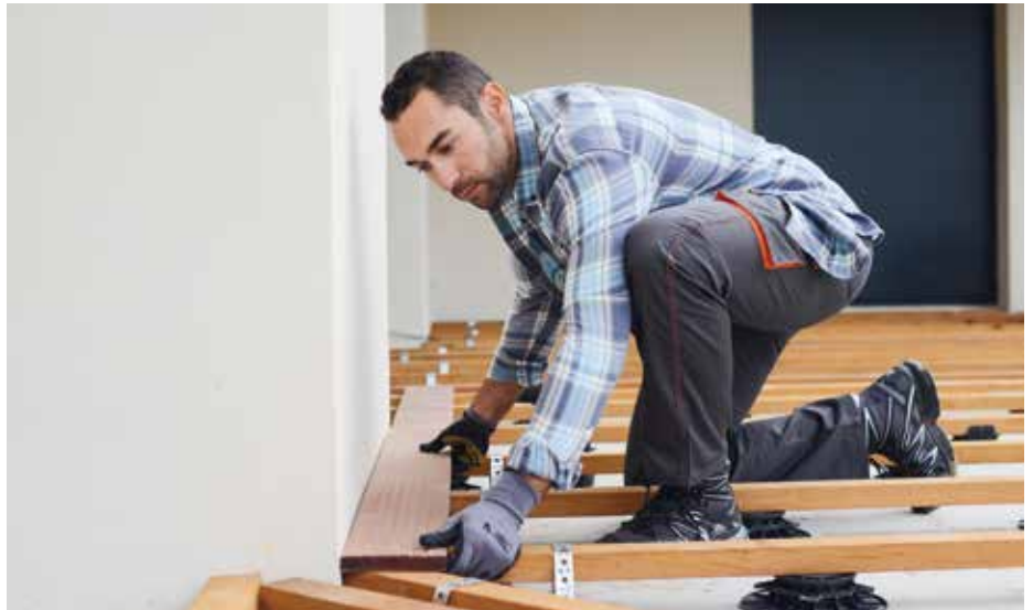
Nach der Fertigstellung unsichtbar, aber enorm wichtig: die Unterkonstruktion – hier auf verstellbaren Stelzlagern
