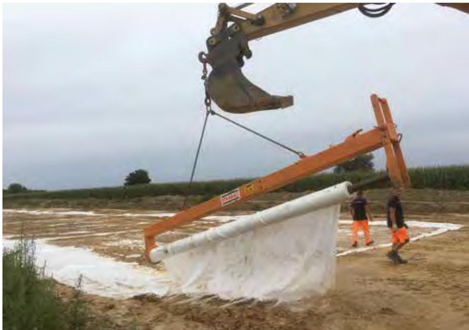
**Verlegung von Kortex GT Hochlastgewebe der Frank GmbH zur Bodenbefestigung und Separation von Bodenschichten.**
