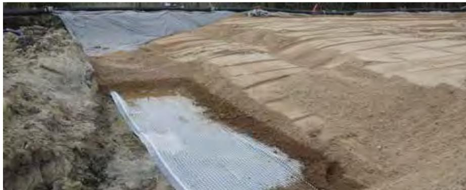
**Armatex RS 40/40 HPQ Geokomposit aus gewebten PET-Geogitter, kaschiert mit PET-Vlies, zur Bewehrung und Trennung von Tragschichten.**
