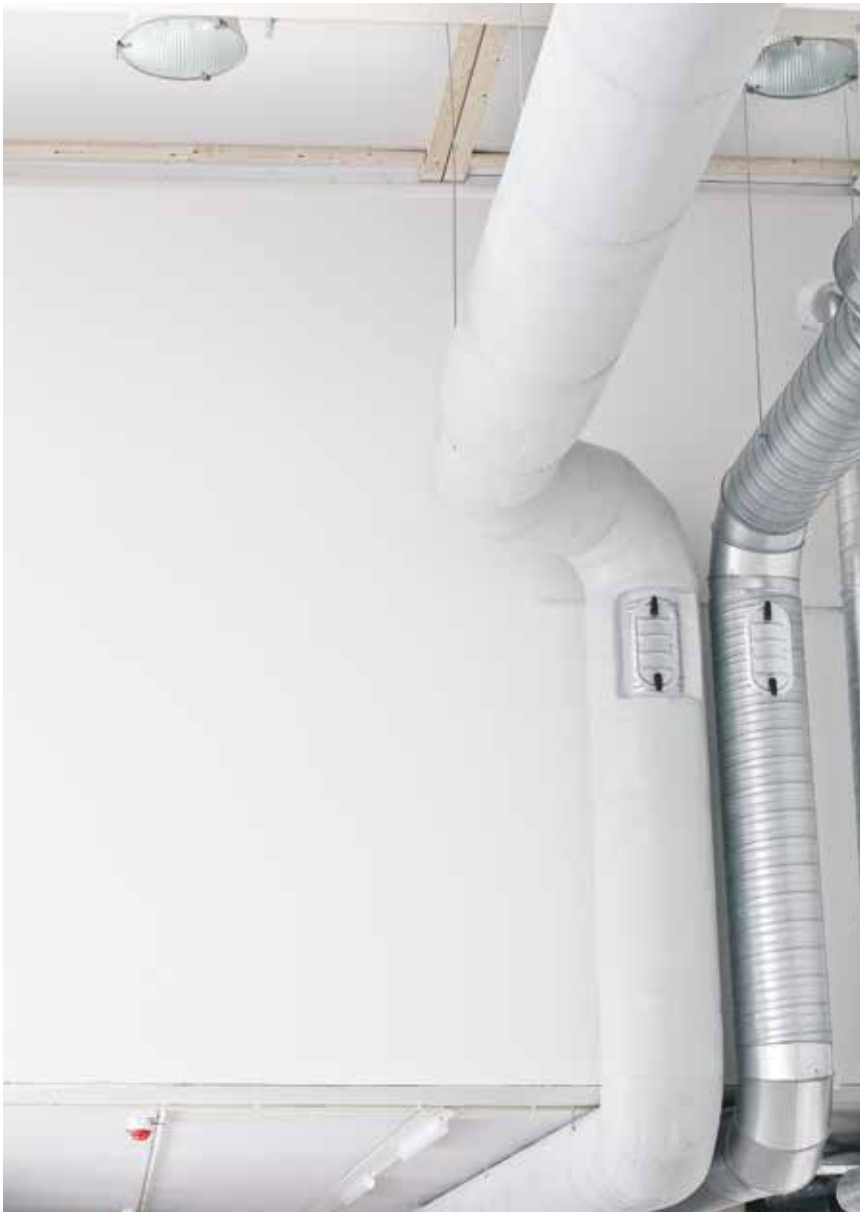
Lüftungskanäle mit PAROC Hvac Lamella Mat GreyCoat isoliert - optisch dem Hintergrund angepasst
