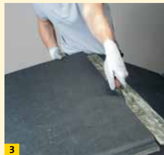
3 Wiederverwendbare Plattenreste abtrennen
