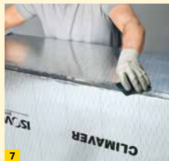
7 Klebeband anpressen – fertig ist das Kanalsegment
