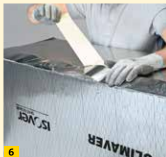
6 Stoß mit CLIMAVER® Klebeband luftdicht verkleben
