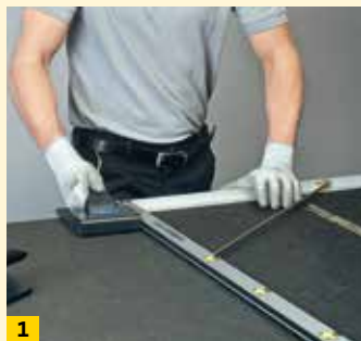
1 Stufenfalz mit CLIMAVER® Werkzeugen herstellen
