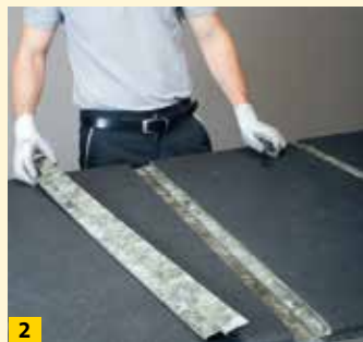
2 Überflüssige Dämmstoffstreifen entfernen
