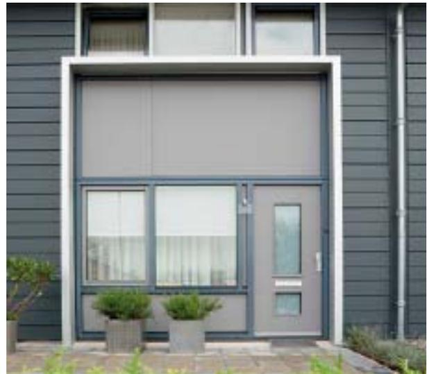
Fassadenpaneele eignen sich ausgezeichnet als Bekleidung für vorgehängte hinterlüftete Fassaden und Giebelverkleidungen. Im Gegensatz zum Naturprodukt Holz benötigen sie keine regelmäßigen Pflegeanstriche, sind frost-, witterungs- und UV-beständig und nicht brennbar.
