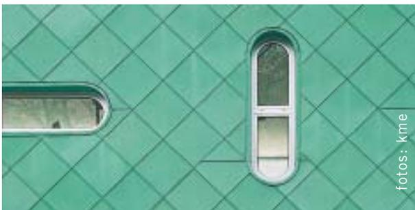
Kupfer ist ein relativ weiches und dehnbares, aber auch besonders widerstandsfähiges Metall, das sich gut verarbeiten und formen lässt. Als Fassadenbaustoff ist es wartungsfrei und fast zu 100 % recycelbar.
