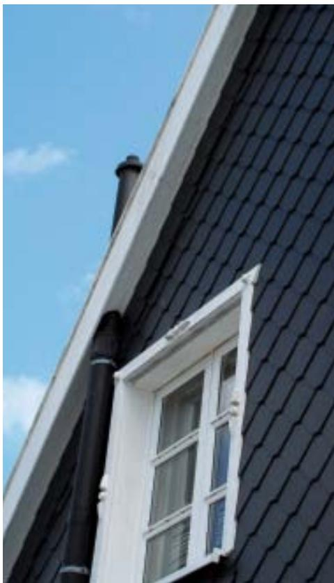
Die **Gezogene Doppeldeckung** überzeugt durch ein ungewöhnliches Flächenbild. Durch Vergrößerung oder Verkleinerung der seitlichen Überdeckungen kann dieses Deckungsbild an die Form der Fassadenfläche angepasst werden. Gleichzeitig ermöglicht sie eine sehr effiziente und somit kostengünstige Verlegung.
