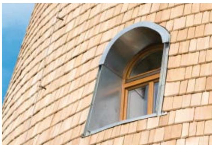
Die vorgehängte hinterlüftete Fassade findet ihren Ursprung in historischen Holzschindelbekleidungen. Diese stammen vornehmlich aus Regionen, in denen die Häuser klimatisch stark durch Niederschläge beansprucht wurden. Das System der VHF bietet hier nicht nur einen optimalen Schutz der Bausubstanz, sondern auch eine ideale Verbindung zwischen behaglichem Klima im Inneren und einem optisch attraktiven Äußeren.
