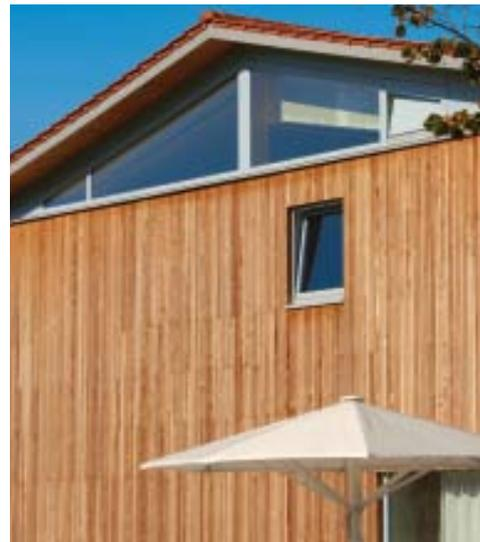
Neben dem Profil prägt auch die Verlegetechnik den Eindruck des Hauses. So kann über die Ausrichtung der Verlegung das Haus optisch in seiner Höhe oder Ausdehnung vergrößert werden. Hohe, schmale Häuser wirken großzügiger durch eine horizontale Bekleidung, während breite, gedrungene Häuser durch vertikale Deckung in ihrer Anmutung proportional gestreckt werden.
