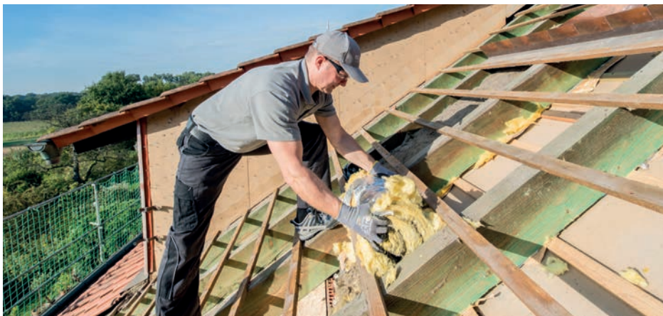
Die Innenbekleidung kann zusätzlich von außen begutachtet werden, wenn die alte Dämmung ausgebaut wird.
