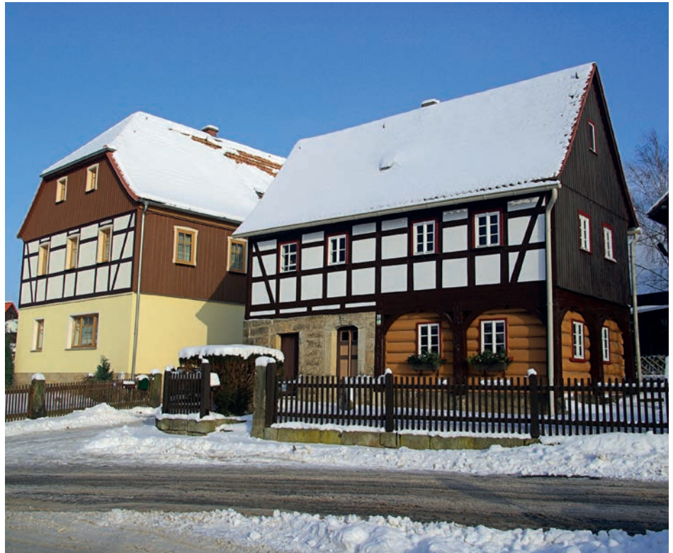
Abb. 4: Giebel an Wetterseiten von Fachwerkgebäuden wurden früher häufig durch eine Bekleidung vor Schlagregen geschützt. Foto: ©Thinkstock/Zoonar
