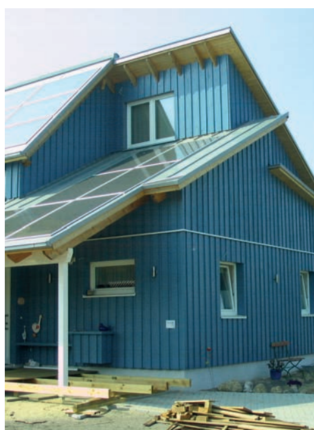
Abb. 4: Der Gebäudesockel weist einen ausreichenden Abstand der Schwelle zu OK Gelände auf. Der Zugang zum Haus erfolgt hier über ein Holzpodest, das Geländeniveau liegt tiefer. Der Eingangsbereich ist durch ein Vordach optimal geschützt.
