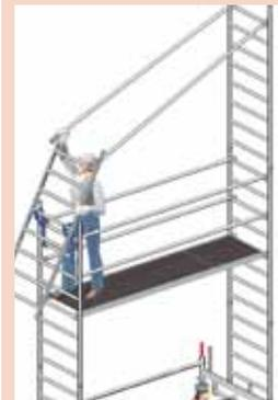
**1** Aufstecken der Standleiter. Anbringen der Uni Montagehaken und Positionierung der zweiten Standleiter zur Montage der Geländerholme.
