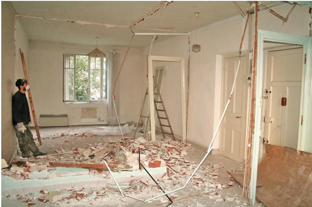
**Auf der Baustelle entsteht Staub. Besonders Feinstaub wirkt sich auf die Dauer auf die Gesundheit aus. Abhilfe leisten Luftventilatoren mit Filtern für Grob- und Feinstaub. Manche Geräte fördert die BG Bau.**
